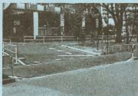
買い物広場の仮駐車場入り口の安全対策を実施
